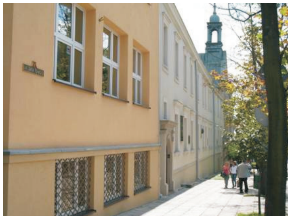
Budynek biblioteki. Widok od ul. Jana Pawła II (2010 r.)
