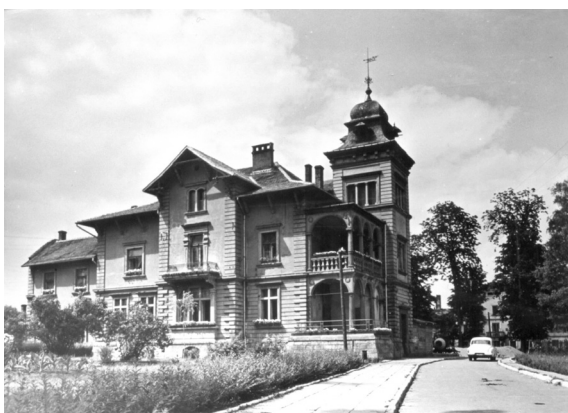
Siedziba biblioteki w budynku Powiatowego Domu Kultury
