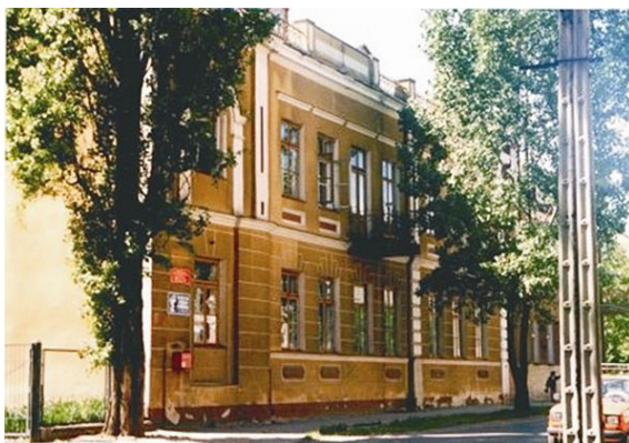
Siedziba biblioteki przy ul. Ilżeckiej
